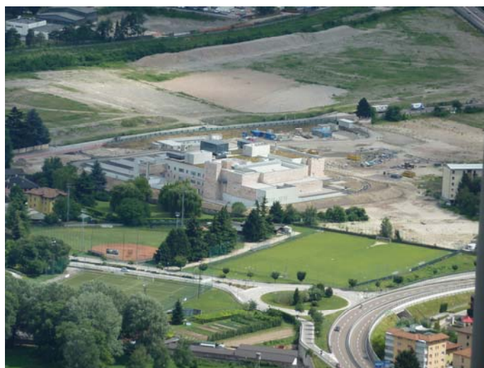
Kliniken ATreP sedd från ovan, med sitt fortlänkande intryck. Bilden är tagen uppifrån berget som syns i bakgrunden av Bild 1 och ner på baksidan av byggnaden. De stora fönstren på byggnaden vetter åt motsatt håll jämfört med det som bilden är tagen ifrån.
