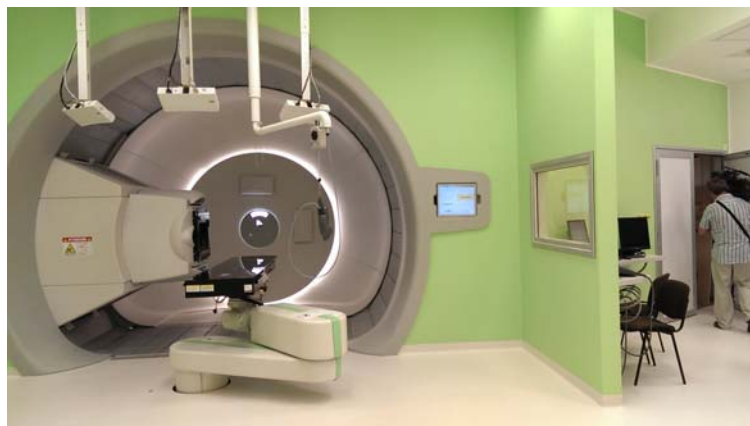
Gantryrum på ATreP, med kåpor på nozzlen och bords-topp monterad för besök från lokal-TV (se kameramannen i höger bildkant). Arbetsstationen bakom den lilla väggen till höger är till för röntgen-bildtagning av patienterna inför behandling.
