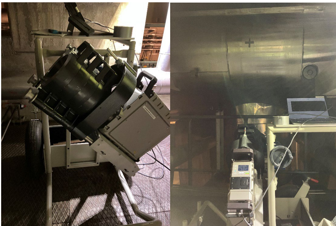
Figur 10: Betongprovtagning av golv.
