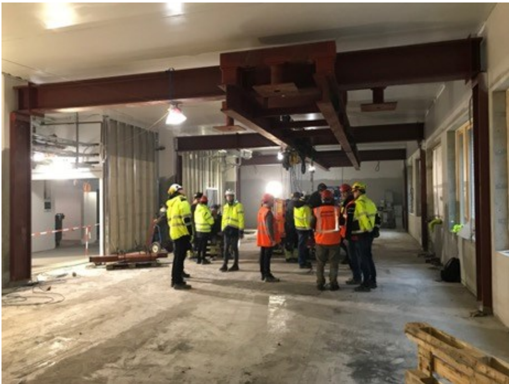
Figur 1: Bild tagen från bakre delen av MR-salen och visar stålstrukturen som bär upp rälsen, transportsystemet och MR-kameran samt tre festen för takhängd utrustning som t.ex. operationslampor och försörjningspendlar.
