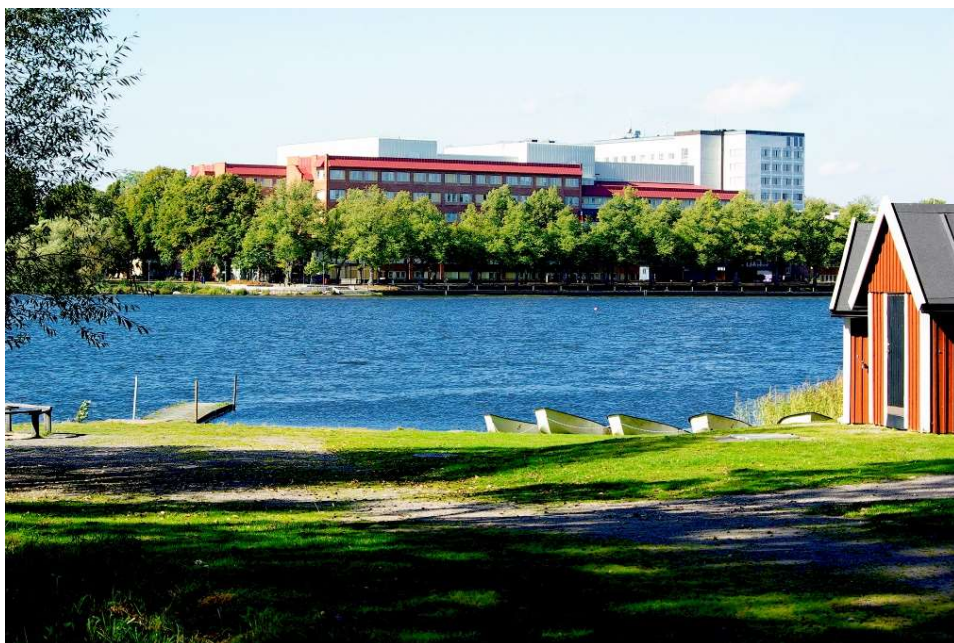
Centrallasarettet i Växjö. Foto: Region Kronoberg
